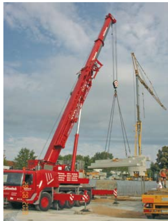
Der 160 t Autokran hebt ein Tribünenenteil in die richtige Position.
