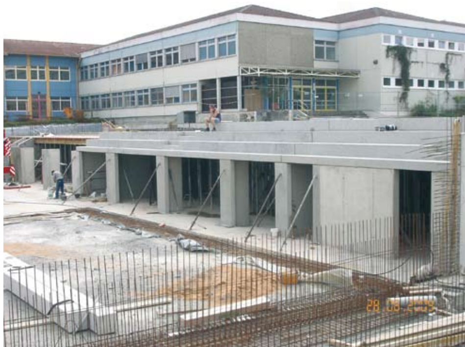
Auf diesem Bild sind die zukünftigen Geräteräume bzw. Zugänge vom Umkleide- in den Sportbereich bereits gut zu erkennen.
